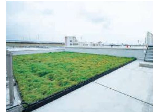
浦和支店 屋上緑地
