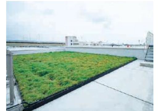
浦和支店 屋上緑地
