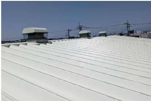
前橋支店 遮熱塗装後の屋根
